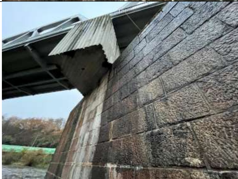
Foto. 3: Pohled na stranu pilíře v poli 1. Patrné výluhy pojiva mezi kvádry.
