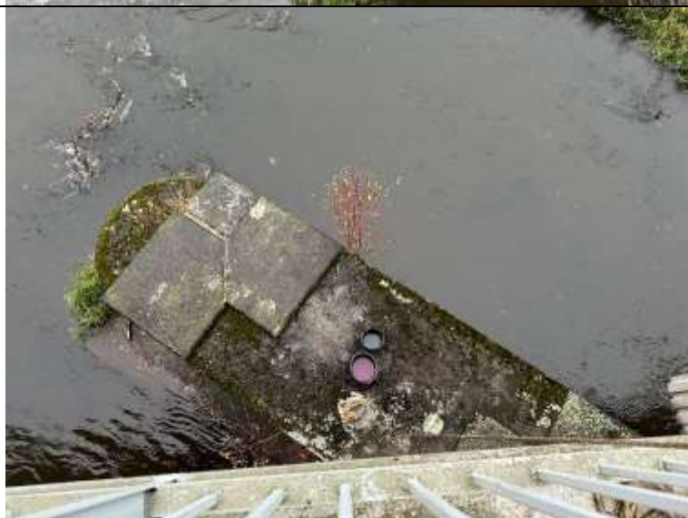
Foto. 23: Pohled na pilíř z NK, horní líc kamenného pilíře pokryt vegetací.
