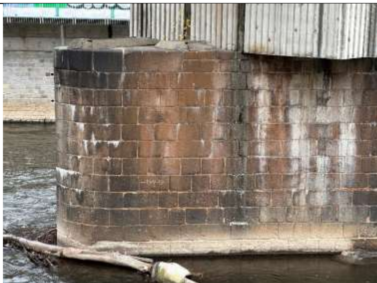
Foto. 19: Pohled na pilíř od opěry OP1, patrné výluhy a zatékání na bok pilíře z úložného prahu. Nánosy naplavenin na návodní straně pilíře.
