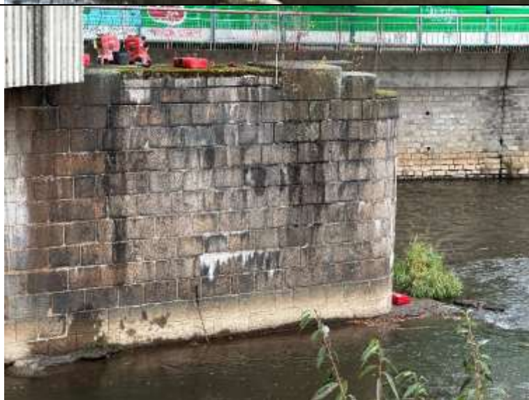
Foto. 20: Pohled na pilíř od opěry OP1, patrné výluhy a zatékání na bok pilíře z úložného prahu. Nánosy vegetace na horním líci kamenného pilíře.
