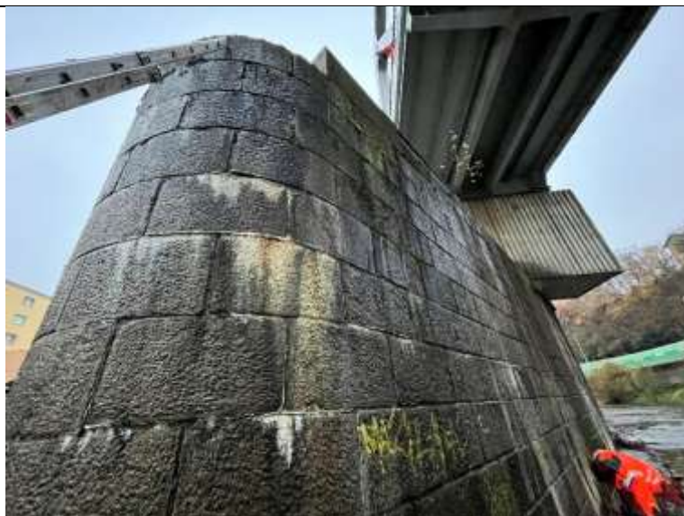
Foto. 13: Pohled na pilíř z pole č.2. Patrné lokální výluhy pojiva mezi kamennými bloky. Výluhy masivnější v místě exponované nezakryté části kamenného pilíře.
