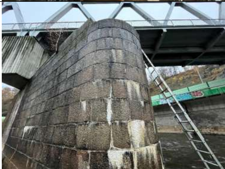
Foto. 2: Pohled na povodní stranu pilíře, patrné výluhy pojiva v kamenném zdivu. Lokálně vyrůstá vegetace na horním líci kamenného pilíře.
