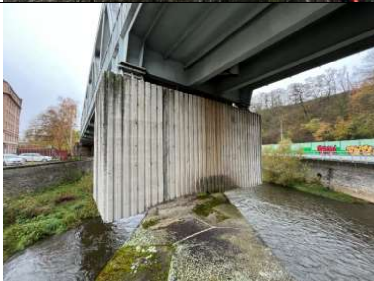
Foto. 14: Pohled na pravou část úložného prahu (z pole č.2). Patrná lokální místa s degradovaným povrchem betonu vlivem zatékání.
