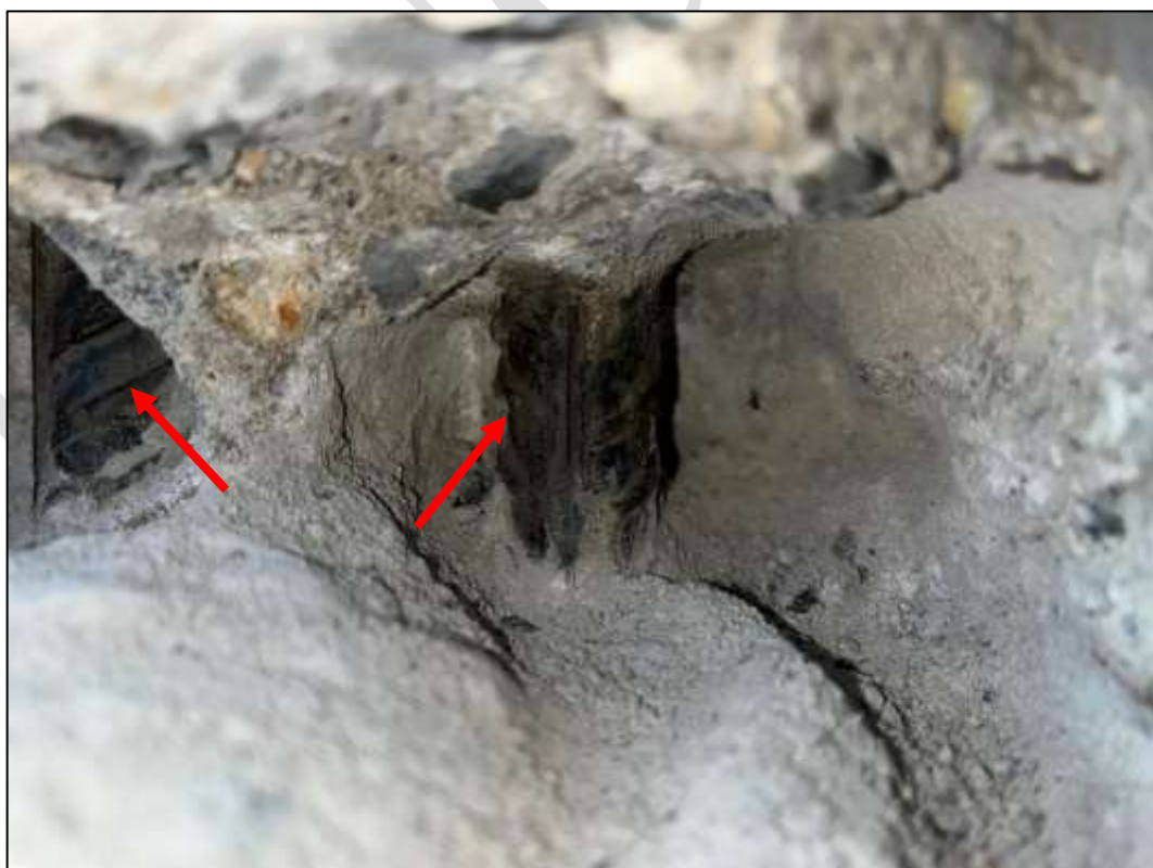
Obr. 18: Sonda 1 a 2 – odhalená svislá výztuž úložného prahu, typ 10425, průměr 20 mm, bez koroze, rozteč výztuží 60 mm – vždy dva pruty v žebří. Krytí 95-100 mm
