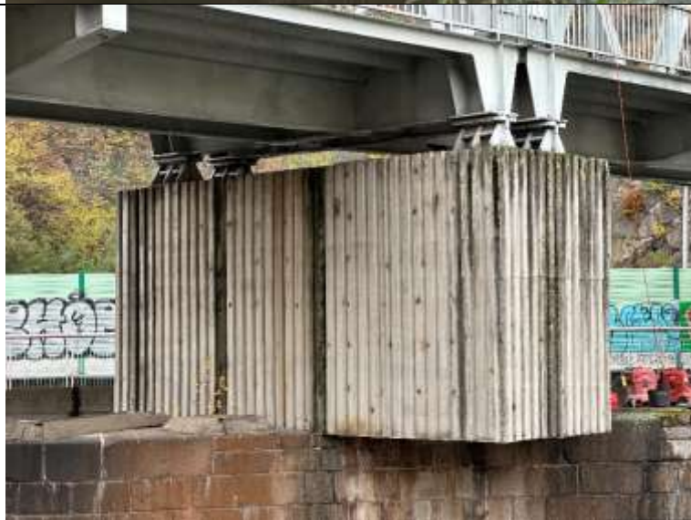
Foto. 21: Pohled na úložný práh od opěry OP1, patrné zatékání na bok úložného prahu.
