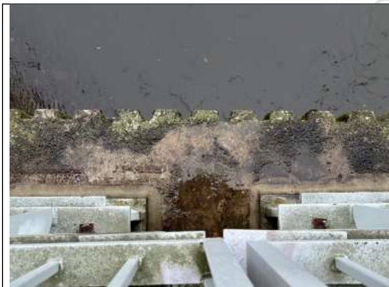
Foto. 26: Pohled na horní líc úložného prahu.
