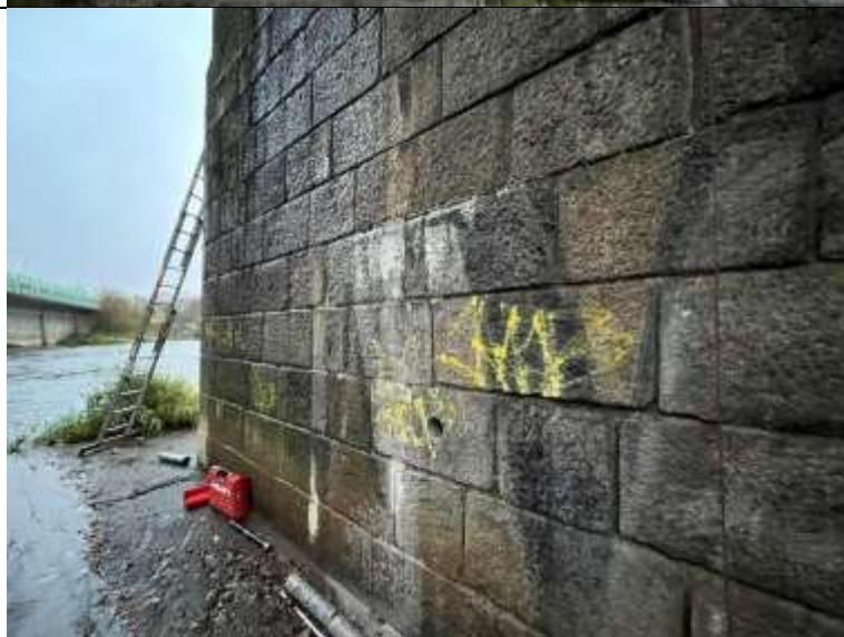
Foto. 12: Pohled na pilíř z pole č.2. Patrné lokální výluhy pojiva mezi kamennými bloky.
