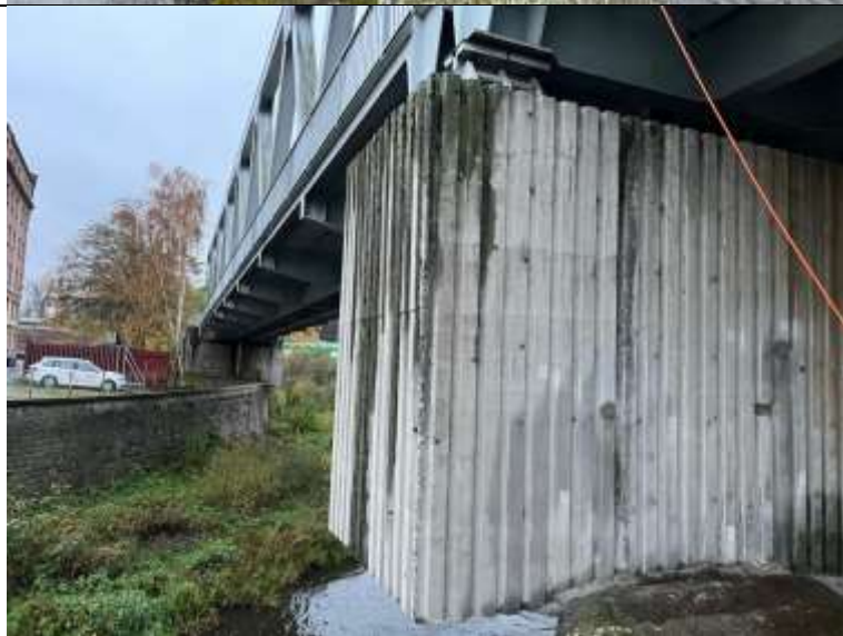
Foto. 15: Pohled na pravou část úložného prahu (z pole č.2). Patrná lokální místa s degradovaným povrchem betonu vlivem zatékání (horní pravá hrana úložného prahu).
