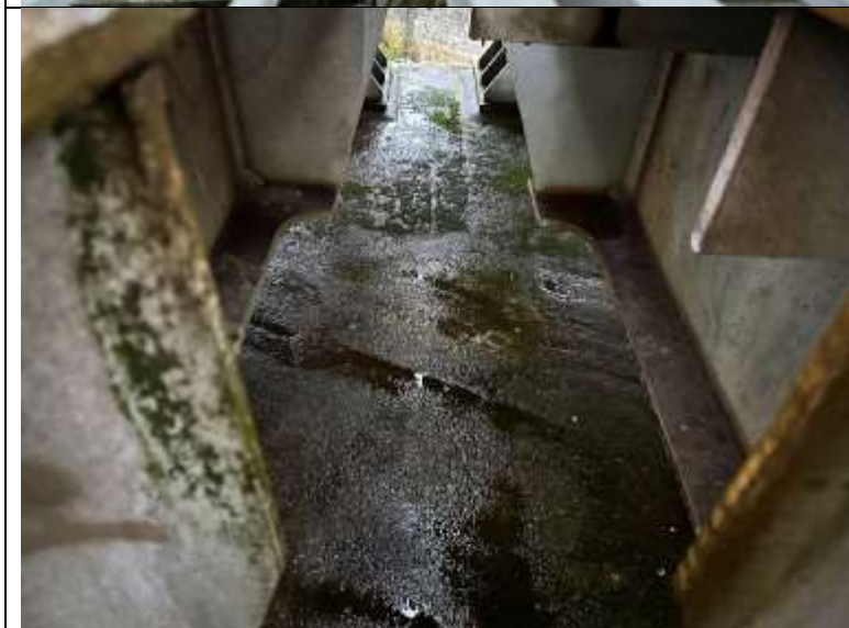
Foto. 27: Pohled na horní líc úložného prahu.
