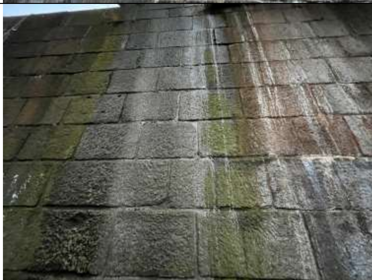
Foto. 11: Pohled na pilíř z pole č.2. Patrné lokální výluhy pojiva mezi kamennými bloky. Stopy po ztékající vodě z nosné konstrukce.
