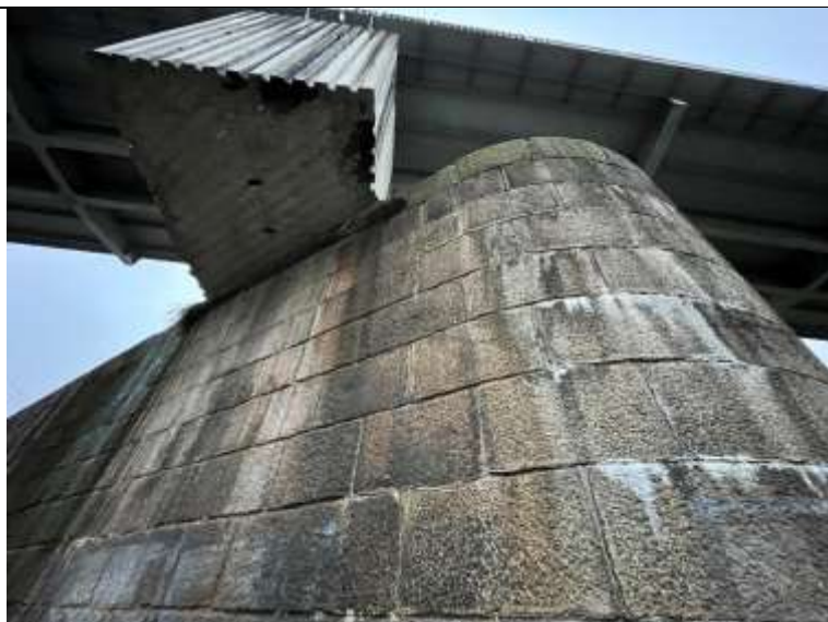
Foto. 10: Návodní strana pilíře, výluhy ze spár na exponované straně pilíře.
