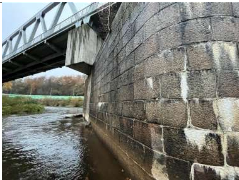
Foto. 1: Pohled na povodní stranu pilíře, patrné výluhy pojiva v kamenném zdivu. Lokálně vyrůstá vegetace na horním líci kamenného pilíře.
