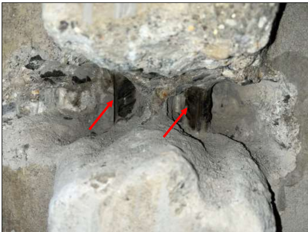
Obr. 17: Sonda 1 a 2 – odhalená svislá výztuž úložného prahu, typ 10425, průměr 20 mm, bez koroze, rozteč výztuží 60 mm – vždy dva pruty v žebří. Krytí 95-100 mm
