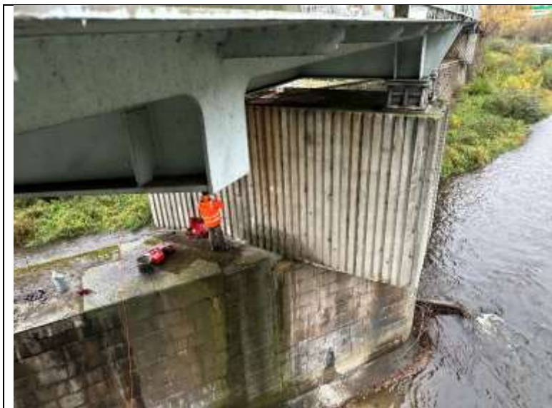
Foto. 25: Pohled na úložný práh a kamenný dřík piliře. Patrné stopy po ztékání vody z NK na horní líc piliře.
