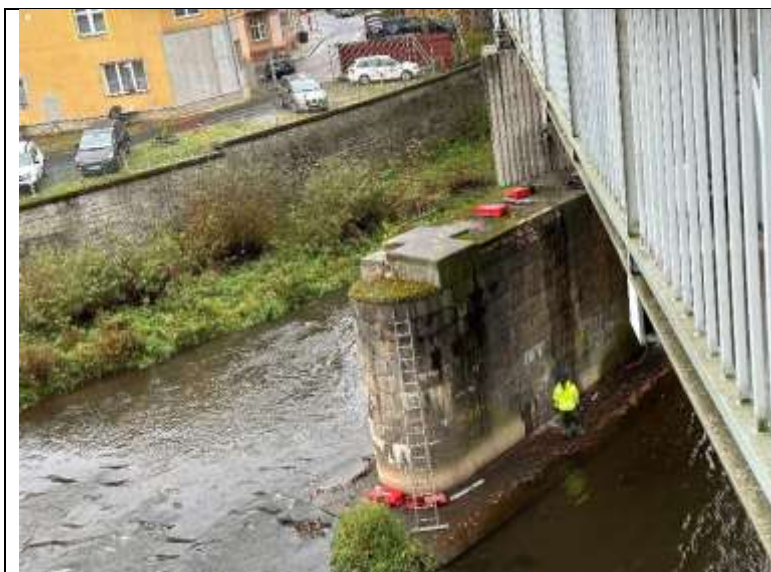
Foto. 22: Pohled na pilíř z K02, horní líc kamenného pilíře pokryt vegetací. Patrné průsaky a výluhy na boku pilíře.
