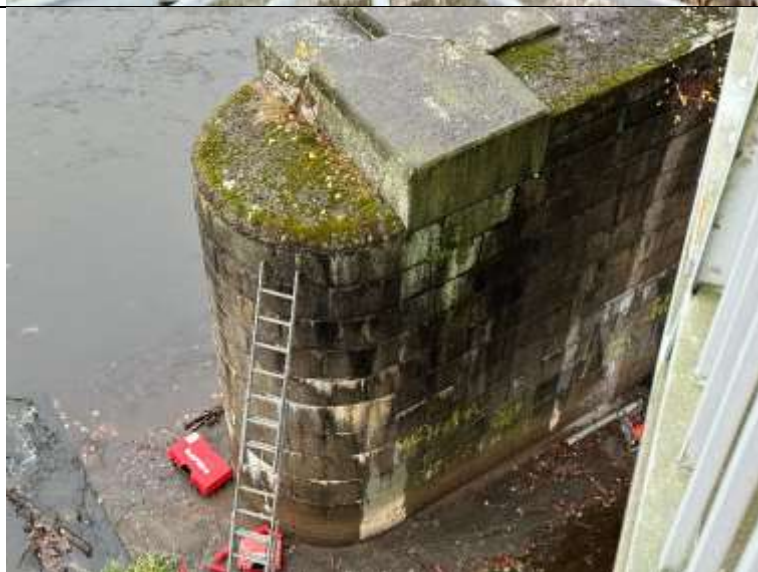
Foto. 24: Pohled na pilíř z K02, horní líc kamenného pilíře pokryt vegetací. Patrné průsaky a výluhy na boku pilíře.
